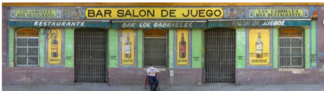
Fig. 5: Fachada del Bar Restaurante Los Gabrieles, c. Marqués de Paradas. Sevilla.
