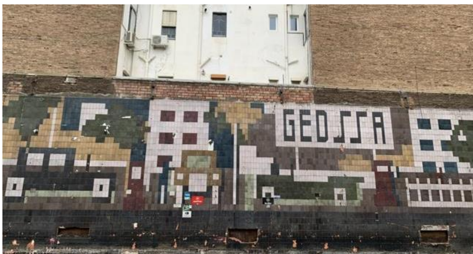
Fig. 35: Azulejo publicitario descubierto al derribar las instalaciones de la antigua estación de servicio Gedssa. Intersección de calle de Provença, Girona y Diagonal. Barcelona.
