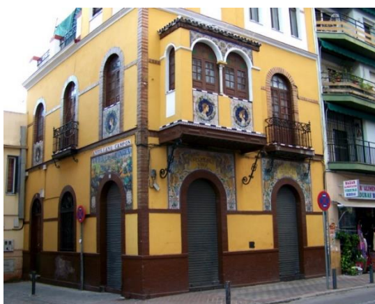
Fig. 3: Edificio de Villa Reinos, c. Pagés del Corro n.49. Sevilla.
