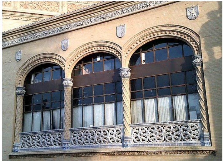
Detalle de ventanales con recubrimiento cerámico
