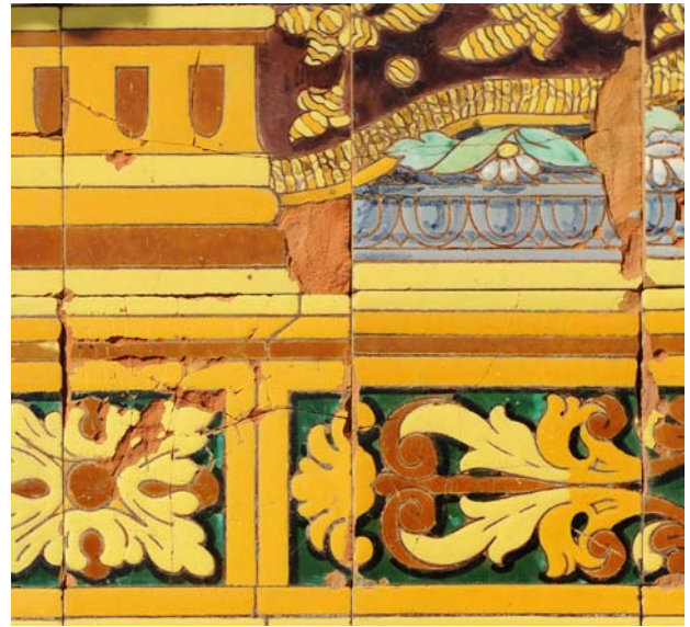
A la izquierda, varillas de hierro oxidadas que aparecen tras el azulejo fracturado. A la derecha, piezas polifracturadas y pérdida de vidriado.
