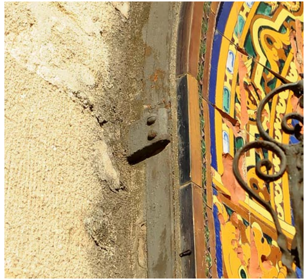
Anclajes de hierro en el muro de piedra y pletina perimetral.
