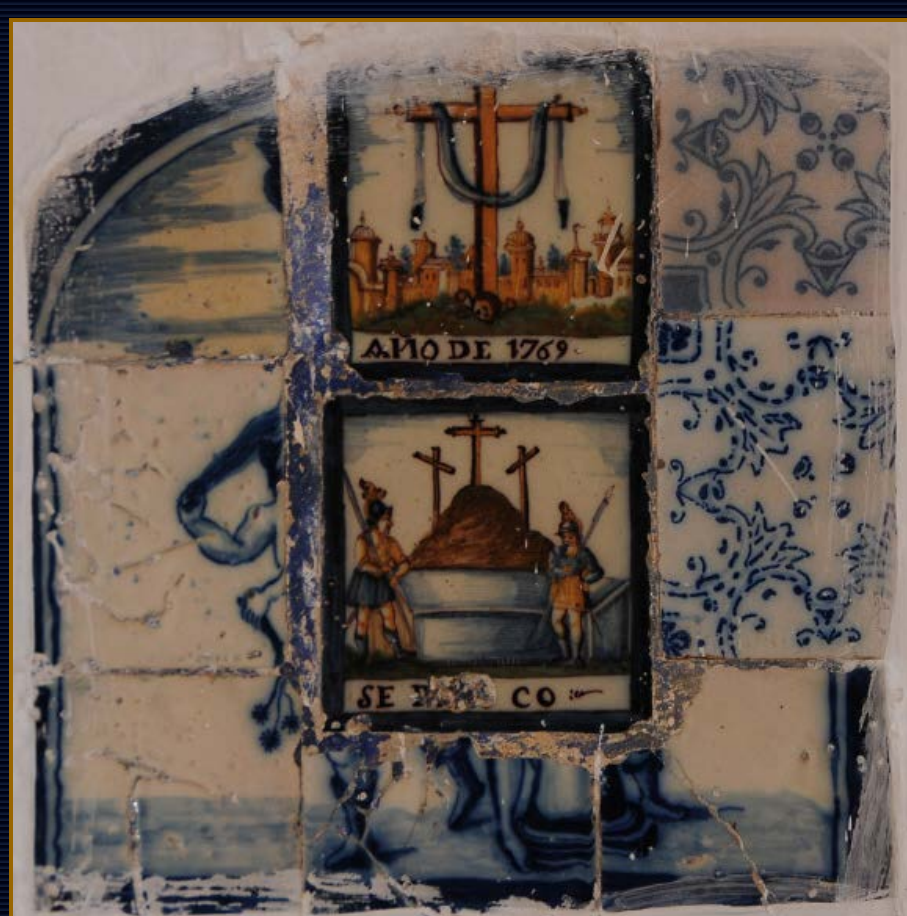
En esta estación se conjugan piezas originales (4,7,8 y 9), azulejos de época sustituyendo a los originales (3 y 6), una pieza mal colocada de las primitivas (1) y 2 piezas nuevas sustituyendo a los azulejos 2 y 5 originales.
