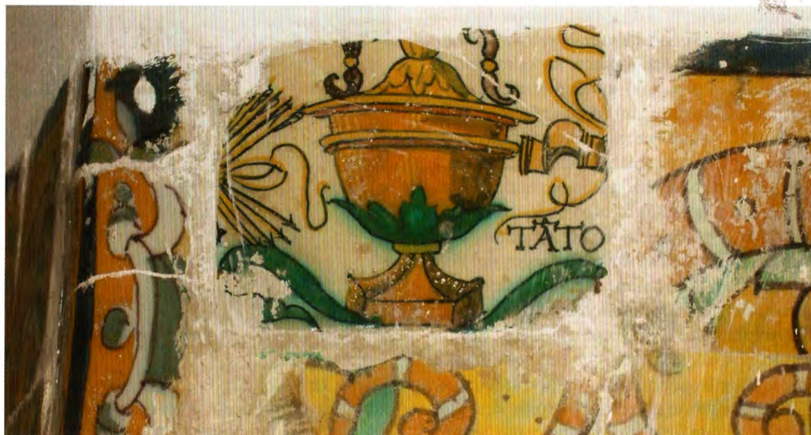
Fig. 18 Niculoso, 1504. Real Alcázar de Sevilla. Sala de la Cantarera. Azulejos reinstalados.
