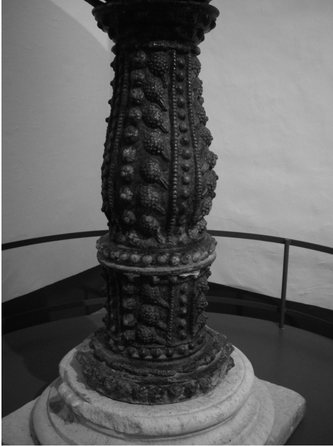
4: Fuste de la pila de Antequera. (Foto JRB)
