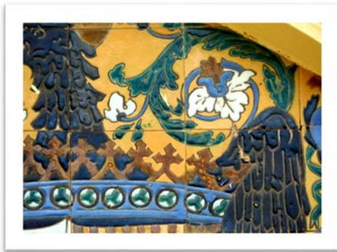
Detalles de la aplicación de la cuerda seca donde se aprecian algunos fallos en su ejecución
