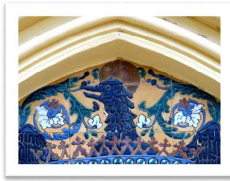
Detalles de la aplicación de la cuerda seca donde se aprecian algunos fallos en su ejecución
