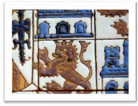
Detalles de la aplicación de la cuerda seca donde se aprecian algunos fallos en su ejecución
