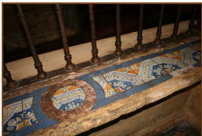
Fig. 3. Revestimiento hecho con azulejos del basamento de la reja de la capilla. Patrón del casetón ochavado. Foto: A. Pleguezuelo.
