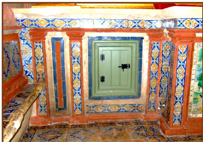
Fig. 2. Parte lateral izquierda del zócalo bajo el retablo. Verduguillos y guardillas. Foto: Pleguezuelo
