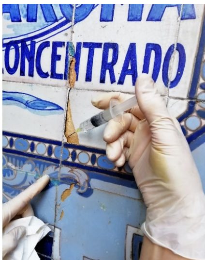
Fijación previa del vidriado
