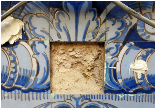
Realización de azulejo de nueva factura y colocación en el lugar de la perdida.
