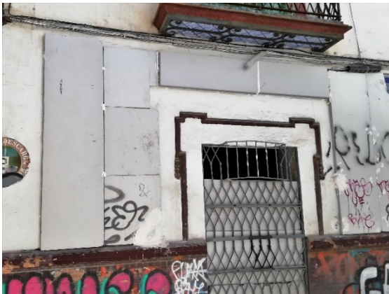
Protección con paneles al inicio de la obra, fachada lateral
