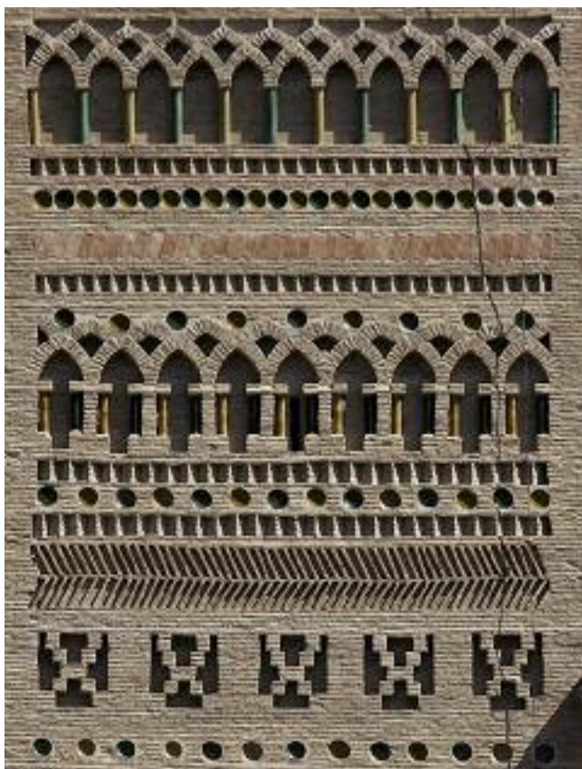
2003. Torre de Santa María de Ateca (Zaragoza). Cuerpo central de la torre. Se aprecian los atafiores y las columnas de 60 cm. En colores verdes y melados. Foto: Antonio Ceruelo.
