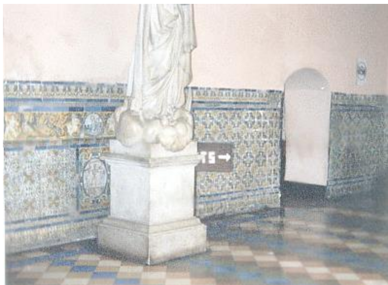
56. Zócalo de azulejos de la ante portería del convento de San Francisco de Lima.
