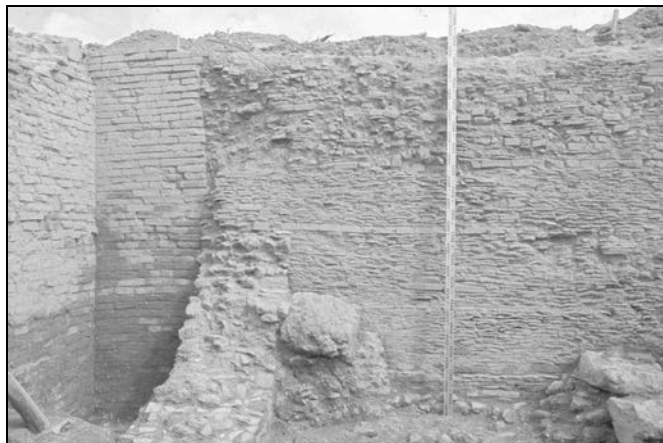
Figura 3.- El Tejarillo, marcas de los cajones para construir el muro y la trabazón de los mismos.
