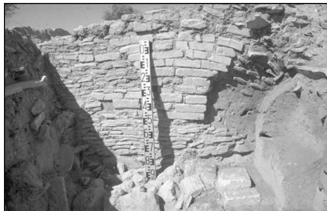
Figura 15.- Hornos de Arva. Detalle del muro perimetral y de la boca de la cámara de combustión.
