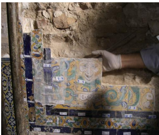
Figura 7. Metodología de extracción: siglado y engasado de protección. En este caso las circunstancias propiciaron la extracción de cada pieza sin ejercer presión sobre los azulejos removiendo manualmente el mortero para evitar roturas (J.J. Lupión).
