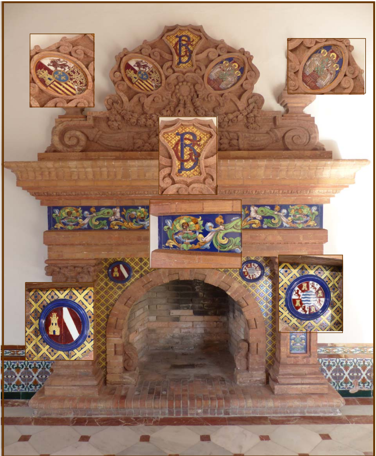
En el centro del salón hay una lujosa chimenea con elementos cerámicos. Hechos con cuerda seca en la Fca. De Hijos de Ramos Rejano
