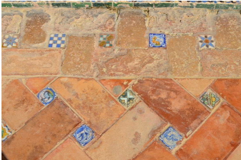
Fotografía nº 3. Vista de los pavimentos de diferentes épocas. La zona que se observa en la parte superior es la que está actualmente en peor estado de conservación y es el original. El de la zona inferior es una reposición moderna del 1998.
