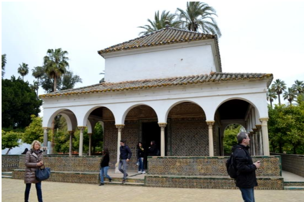
Fotografía nº1. Vista exterior del Cenador desde el alzado Sur. Todas las fotografías de este trabajo han sido realizadas por Clara Tabales Rivas.
