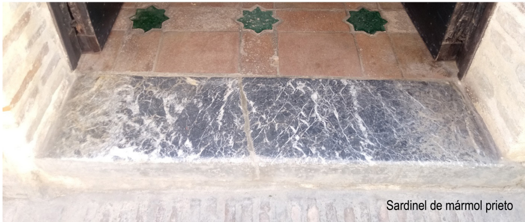
Fig. 1. Sardinetes de ladrillo y de mármol prieto jaspeado en casas sevillanas en la actualidad [Fuente: La autora].
