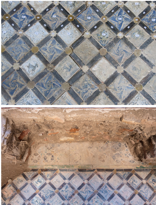
Fig. 7. Detalle de la almadraya en su encuentro con el alizar del interior de la sala (arriba). Detalle del hueco de la puerta donde la almadraya interrumpía su diseño por otro en cuerda seca, el portal en la parte inferior y la sala en la superior. [Fuente: Carmen Riego y José Morón].
