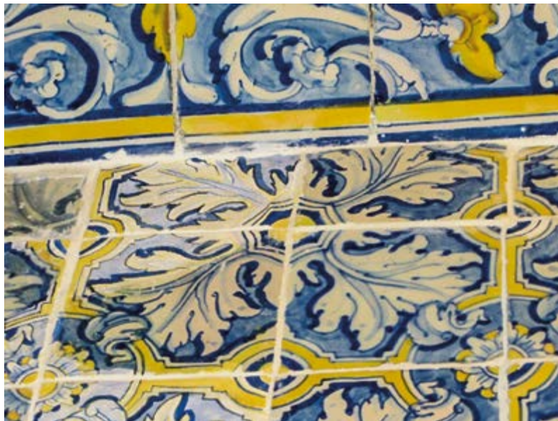
Fig. 10. Azulejos reintegrados con acuarela.
