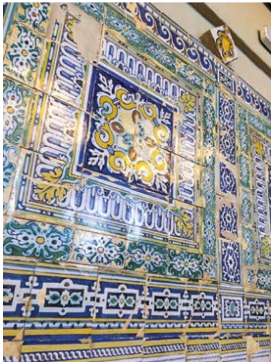
Fig. 5. Detalle del zócalo de azulejos del antiguo refectorio de San Vicente Ferrer.
