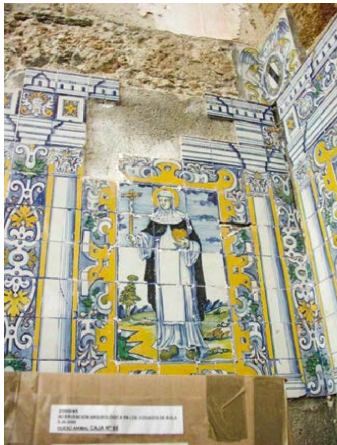
Fig. 15. Estado del retablo antes de su arranque de la sacristía.
