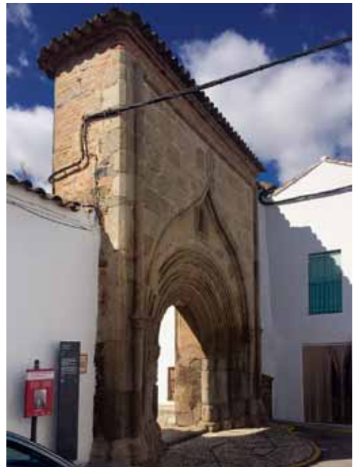
Fig. 45. Estado actual de la portada del convento de Santa Clara. Fotografía: Dña. Ana García Martín.
