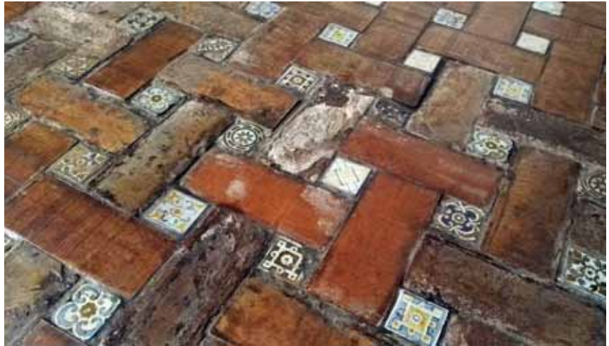
Fig. 57. Olambrillas originales y restauradas en la solería de la sala De profundis . Fotografía: D. Alberto Pino González.
