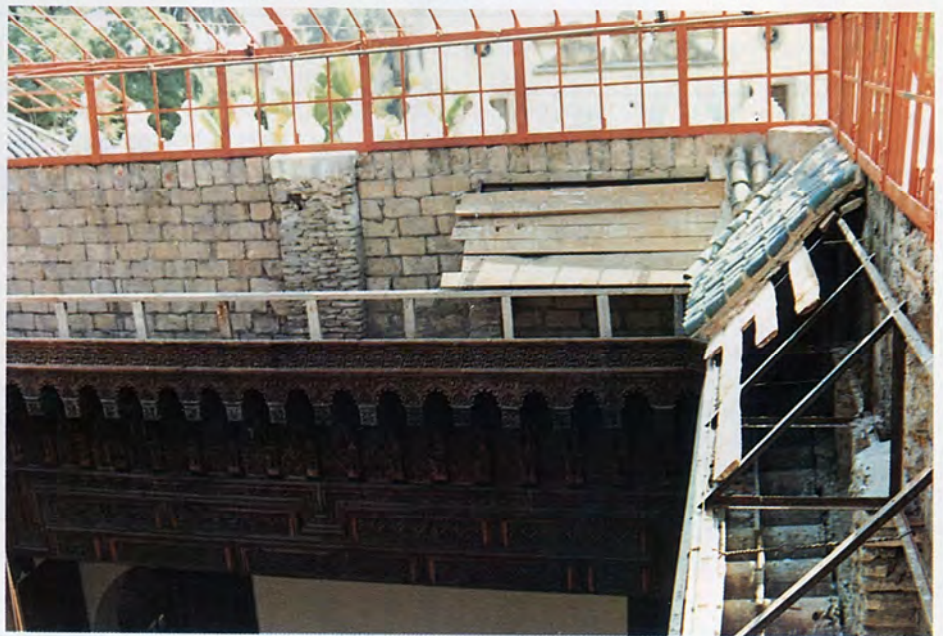
Parcial constructivo del pabellón.
