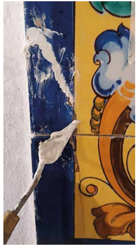
Arriba, de izquierda a derecha relleno con mortero, colocación de las piezas y relleno con mortero y estucado de las lagunas. Abajo, a la izquierda, reintegración cromática, que en las dos fotos siguientes puede verse en detalle el proceso (foto central) y el resultado tras el relleno de las llagas y la reintegración de los esmaltes de los azulejos (Fotos: Ángeles Arjona Guajardo-Fajardo y Victoria Gómez de Lara Caro)
