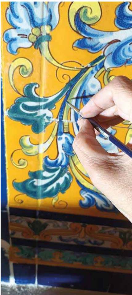
Arriba, de izquierda a derecha relleno con mortero, colocación de las piezas y relleno con mortero y estucado de las lagunas. Abajo, a la izquierda, reintegración cromática, que en las dos fotos siguientes puede verse en detalle el proceso (foto central) y el resultado tras el relleno de las llagas y la reintegración de los esmaltes de los azulejos (Fotos: Ángeles Arjona Guajardo-Fajardo y Victoria Gómez de Lara Caro)
