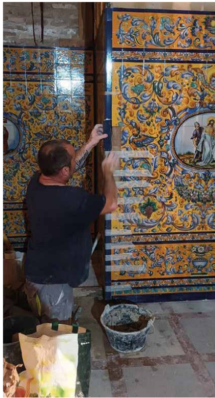
Arriba, de izquierda a derecha relleno con mortero, colocación de las piezas y relleno con mortero y estucado de las lagunas. Abajo, a la izquierda, reintegración cromática, que en las dos fotos siguientes puede verse en detalle el proceso (foto central) y el resultado tras el relleno de las llagas y la reintegración de los esmaltes de los azulejos (Fotos: Ángeles Arjona Guajardo-Fajardo y Victoria Gómez de Lara Caro)
