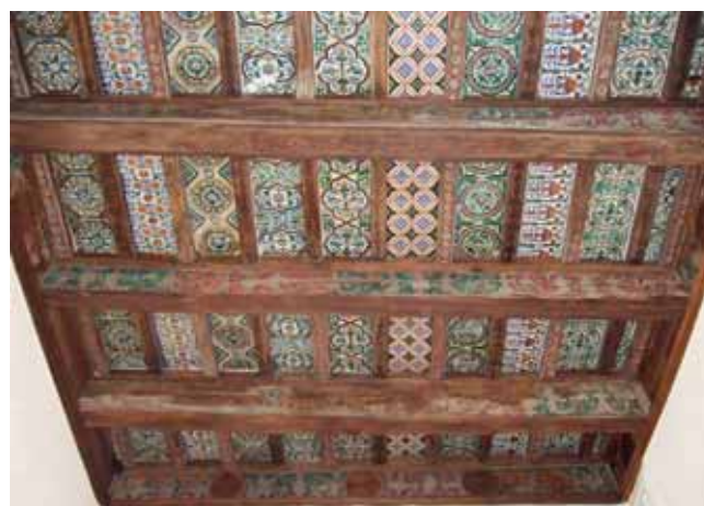
10. FORJADO DE VIGAS, ALFARJÍAS Y AZULEJOS POR TABLA. ANTIGUO CONVENTO DE SANTA CLARA. SEVILLA. FOTO: PLEGUEZUELO.
