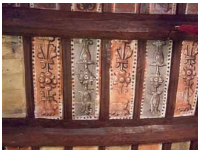
3. TECHO DE VIGAS, ALFARGÍAS Y LADRILLOS POR TABLA PINTADOS AL TEMPLE. MONASTERIO DE LA ENCARNACIÓN. OSUNA. FOTO: PLEGUEZUELO.
