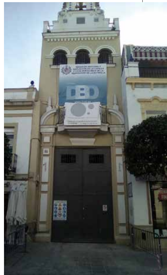
Estado de la fachada de la Capilla de la Estrella antes de iniciar las obras.
