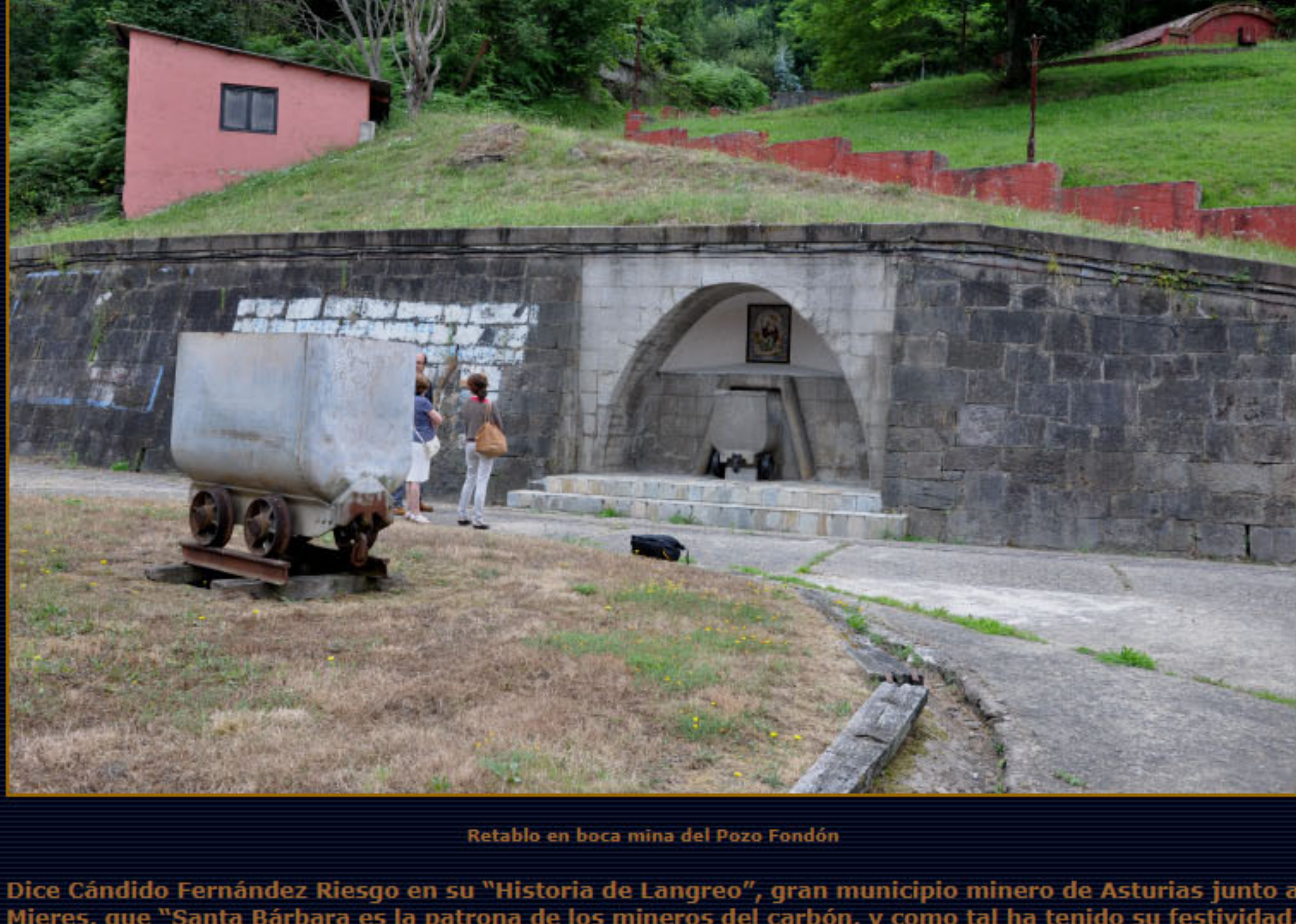
Retablo en boca mina del Pozo Fondón
