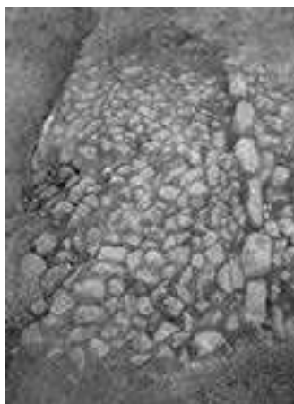
Fig. 16: Restos del antiguo empedrado que pavimentaba la lonja de la ermita.
