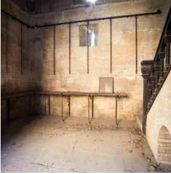
Fig. 73 Estado actual de la sala inferior de la Torre Don Fadrique con restos de cadenas y encimera para colocación de elementos en la instalación original del museo (2014). Fotografía: Pepe Morón.
