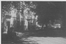
Vista parcial de la plaza de Santa Ana. Se observan las edificaciones ruinosas y el mal estado del pavimento y de la plaza.
