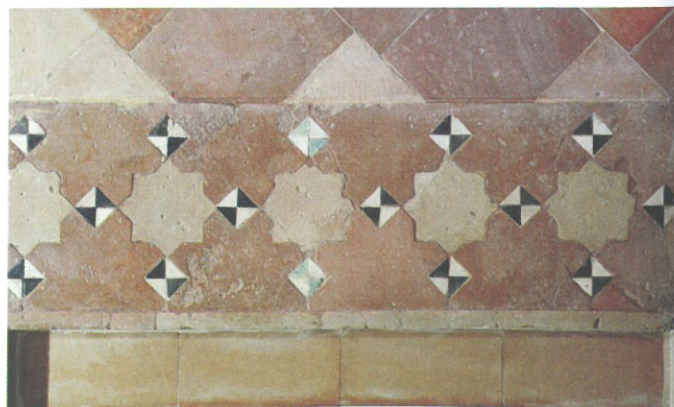
Fig. 4. Umbral de ladrillos de junto, bicolors y olambrado. Palacio de los Condes de Altamira (Casas de Yuçaf Pichón) (fotografía José Ramón Pizarro)
