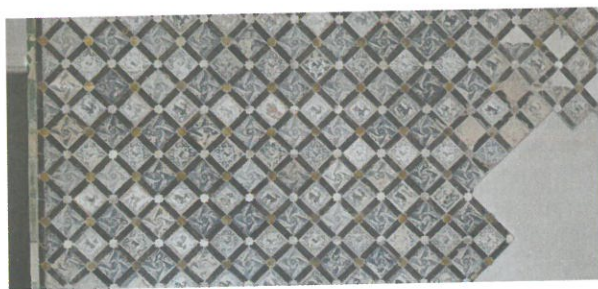
Fig. 6. Almatraya de azulejos valencianos y tablillas y olambrillas sevillanas. Casa en calle Guzmán el Bueno, 11, Sevilla (fotografía, cortesía de Ricardo Alarios)
