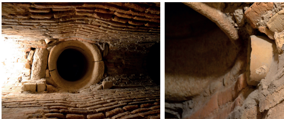
Figura 6. Cañería que conecta al aljibe con el Patio de los Naranjos a través de atadores, instalados en 1487 (fotografías del autor).
