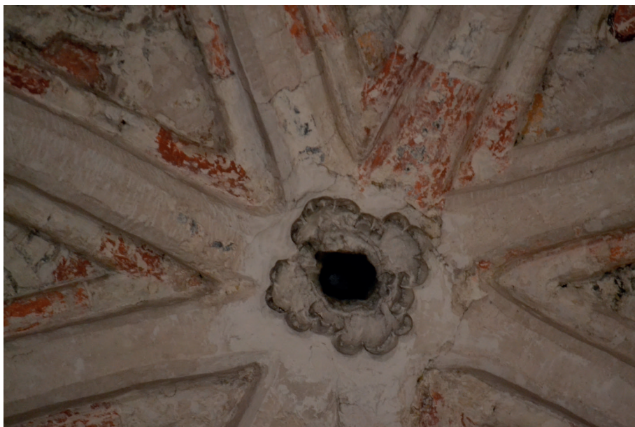
Figura 8. Atanor floreado de la Capilla del Órgano, instalado en 1520 (fotografía del autor).
